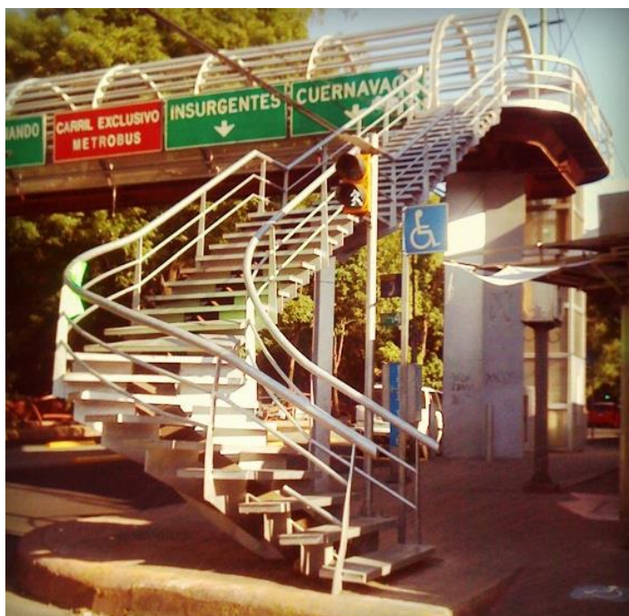
Puente peatonal con ascensor en avenida Insurgentes Sur
