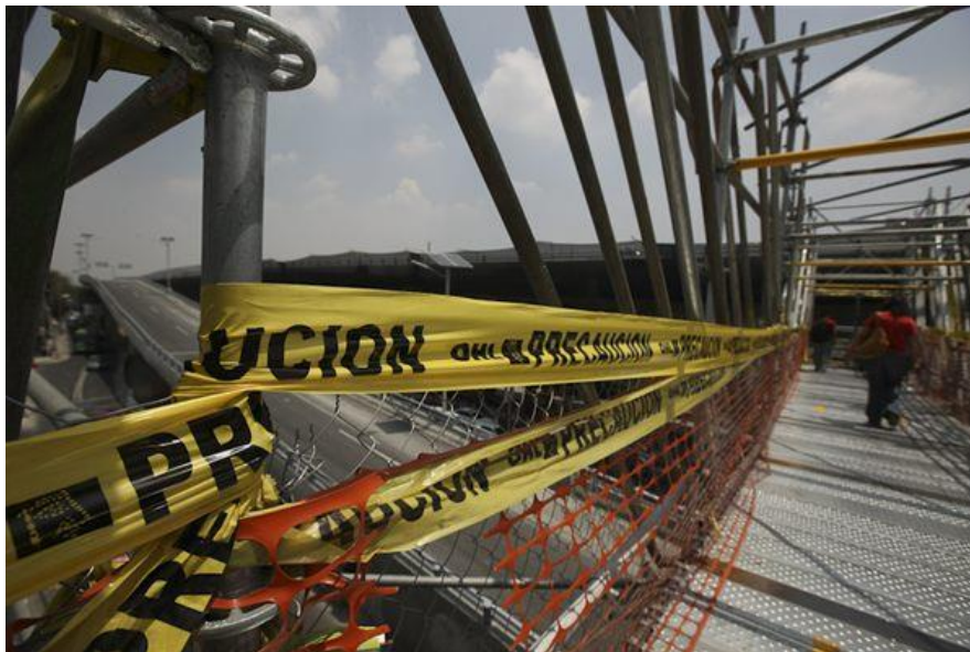
Puente provisional en Periférico. Foto de Aarón Borrás
